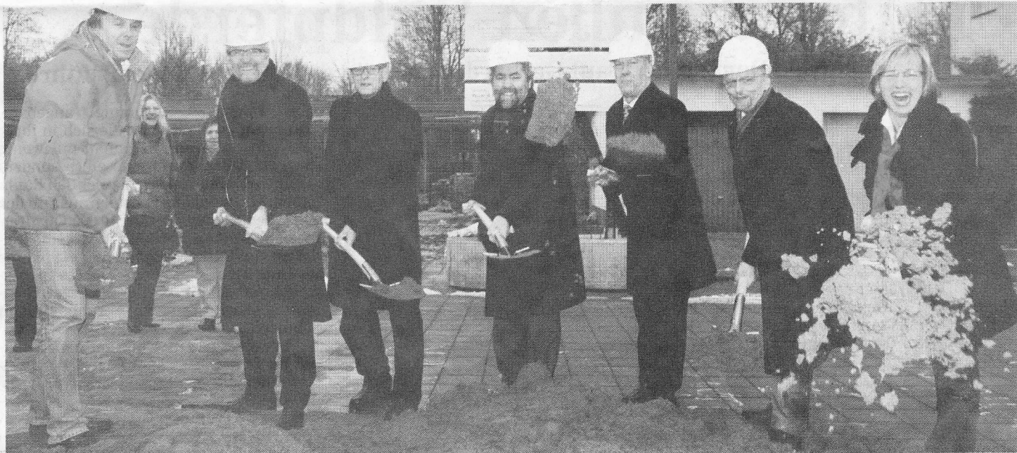
Kraftvoll angepackt: Vertreter des Magistrates, der Verwaltung und der Schule beim gestrigen Baubeginn für die Mensa der OHS. Foto: Paul
